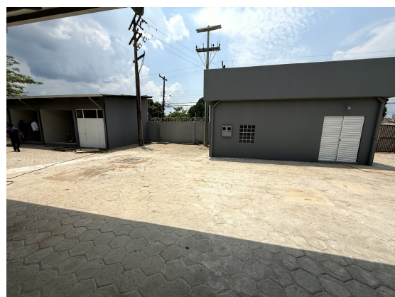
Local de Instalação do Grupo Gerador
