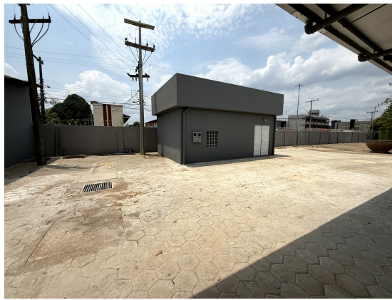
Local de Instalação do Grupo Gerador
