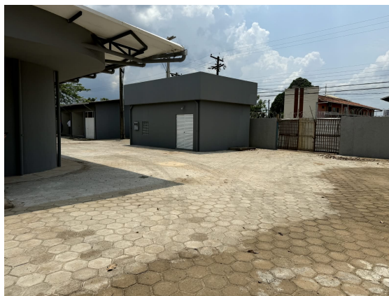
Portão de acesso
