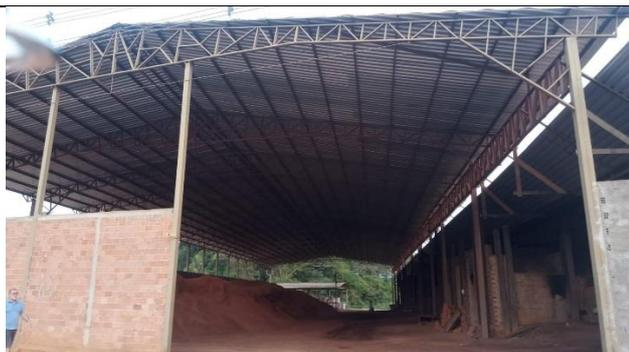
Fig. 02: Ampliação com uma cobertura metálica executada, porém inexistente execução de forro PVC, piso granilite, ou pintura com tinta azul na estrutura, conforme informa o atestado apresentado.
