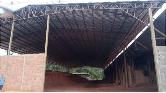
Fig. 05: Ampliação com uma cobertura metálica executada, porém inexistente execução de forro PVC, piso granilite, ou pintura com tinta azul na estrutura, conforme informa o atestado apresentado.
